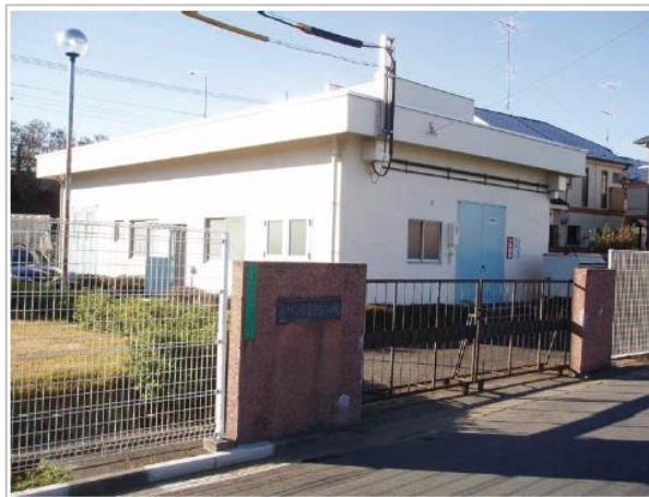
図 3-2-14-4 押立ポンプ場 外観
