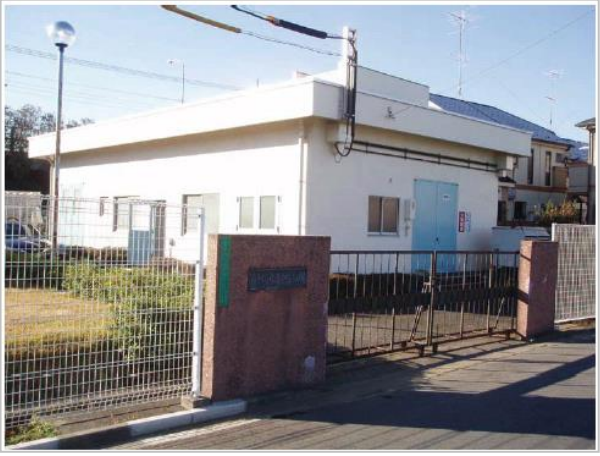
図 3-2-14-4 押立ポンプ場 外観
