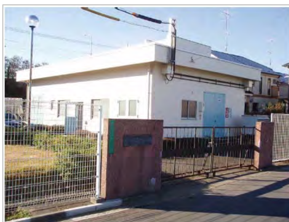
図 3-2-9-4 押立ポンプ場 外観
