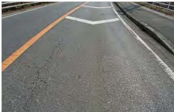
図 3-2-2-2 MCI = 5 ひび割れが見える程度
