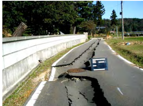
埋戻し砂の液状化による道路の沈下
