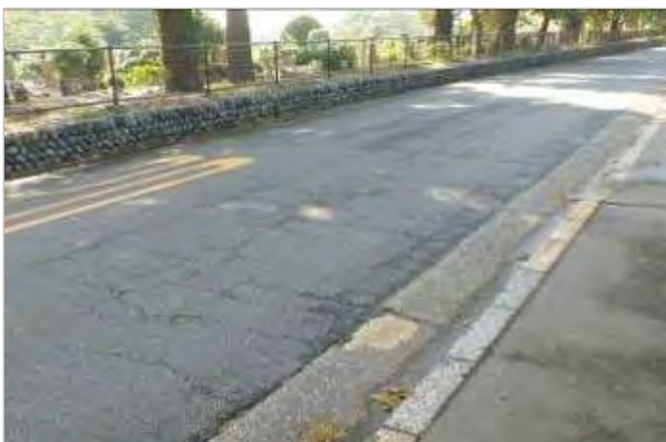
図 3-2-2-4 MCI = 3 ひび割れが面状にひろがり、わだちが顕著
