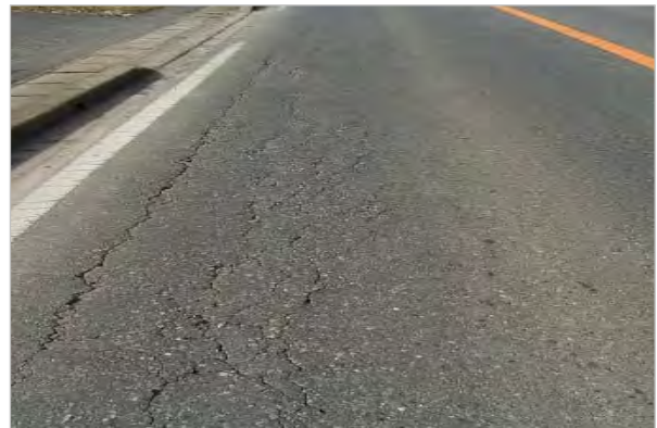
図 3-2-2-3 MCI = 3.5 ~ 4 ひび割れが複数ある程度
