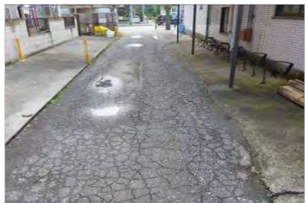
図 3-2-2-5 MCI = 2 ひび割れが全面にひろがり、わだち掘れが顕著
