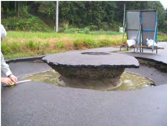
液状化によるマンホールの浮上
