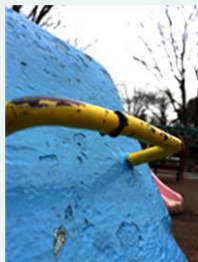
公園遊具の手摺が折れた事例
