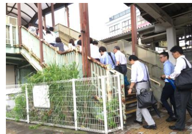
老朽化が進み、幅の狭い跨線橋
