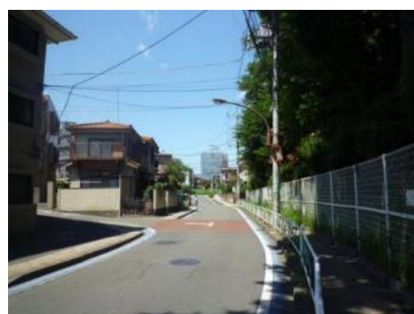
歩道の幅員が狭く、車道に向かって傾斜している
