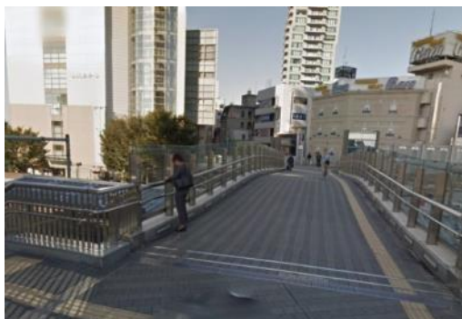
線路をまたぐ跨線橋（デッキ）
