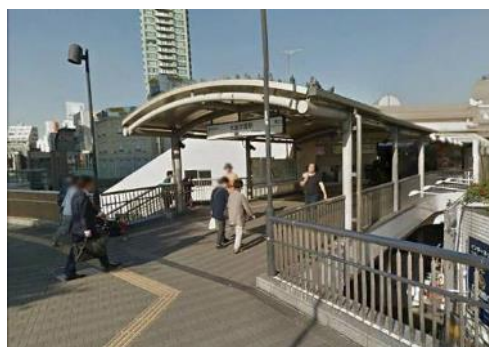
駅改札から繋がる跨線橋（デッキ）
