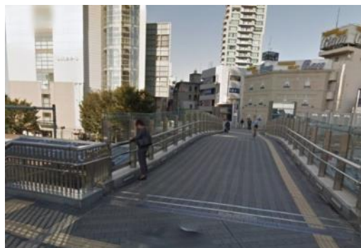
線路をまたぐ跨線橋（デッキ）
