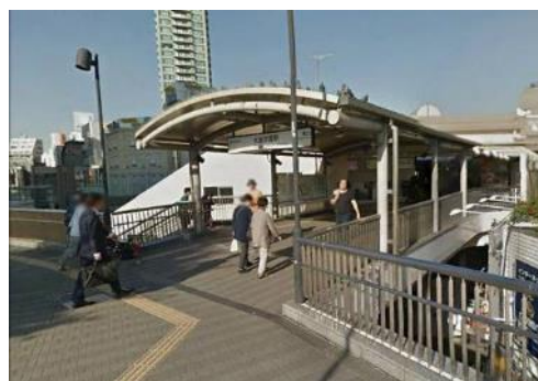
駅改札から繋がる跨線橋（デッキ）
