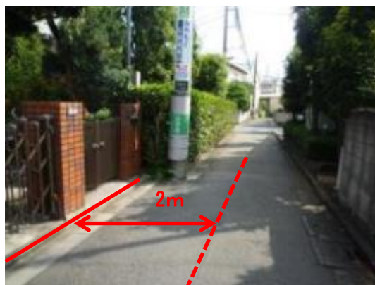
狭あい道路を拡幅整備した箇所
