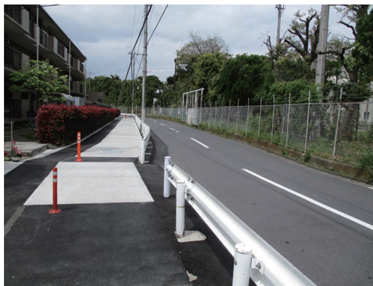
市道6-306号(水路蓋改修)
