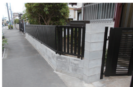
ブロック塀の安全対策 整備後
