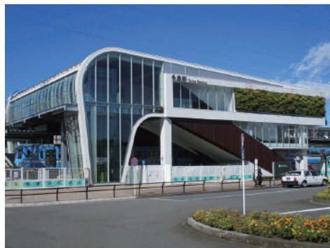
駅舎橋上化及び自由通路が整備された多磨駅
