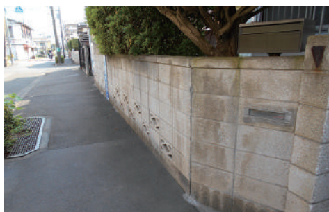
ブロック塀の安全対策 整備前
