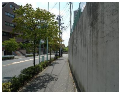
写真 10 国司館地区東の府中街道 (切り通し道路) のよう壁
