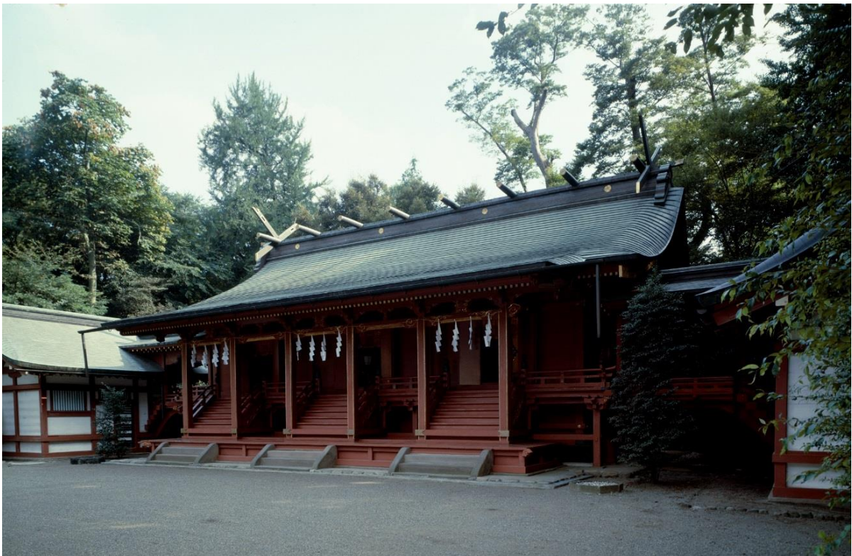
写真 1 東京都指定有形文化財（建造物）大國魂神社本殿
