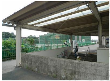
北部の線路脇線に降りる階段
