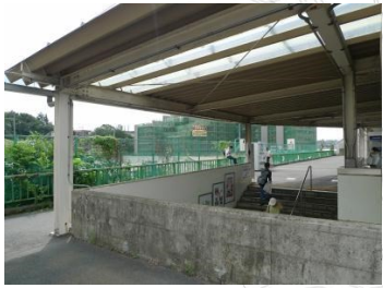
北部の線路脇線に降りる階段
