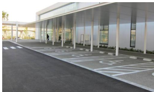
車いす駐車場(つくば市庁舎)
