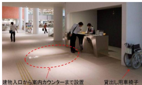
建物入口から案内カウンターまで設置 点字ブロック・入口案内カウンター(町田市庁舎)
