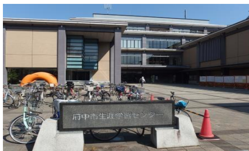
生涯学習センター（宿泊施設）
