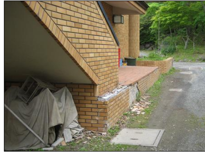
宿泊棟の外壁 コンクリート下地のひび割れによるタイルの浮き
