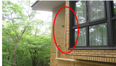
宿泊棟の外壁 コンクリート下地のひび割れによるタイルの浮き
