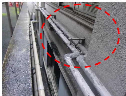
〔外壁の建具や配管類〕
