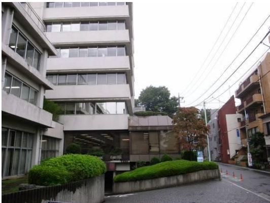
写真 11. 南側駐車場入口
