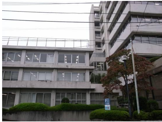
写真 10. 西庁舎東庁舎接続部
