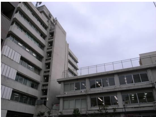
写真 17. 東庁舎と西庁舎の接続部
