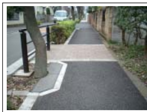
「ツリーキーパー」を活用した幅員の確保
