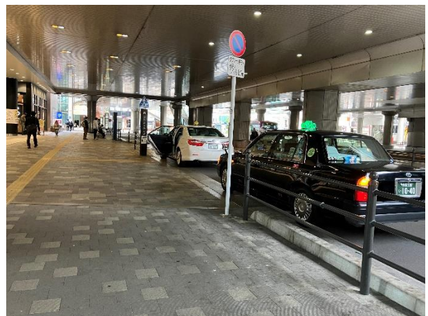
◎タクシー乗り場は平坦部が確保され、連続した視覚障害者誘導用ブロックが設置されている。
