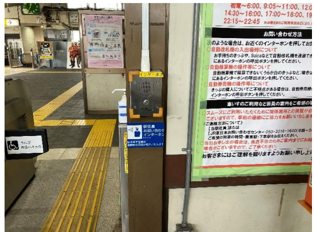
◎券売機付近にインターホンが設置されている。
