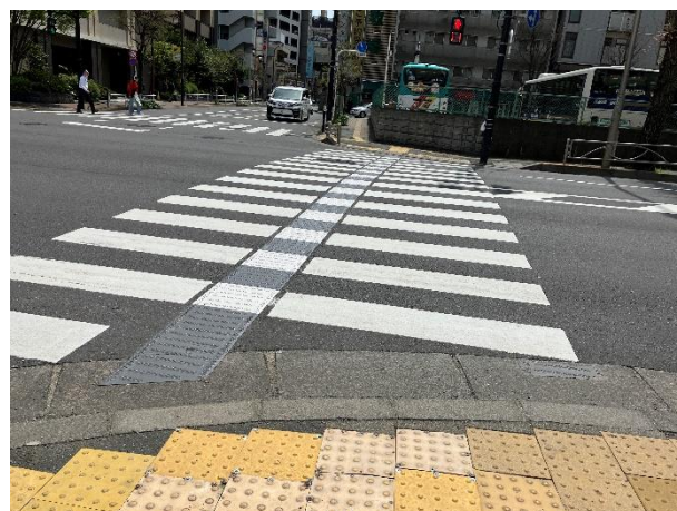
◎エスコートゾーンが敷設されており、視覚障害者が安心して横断できる。
