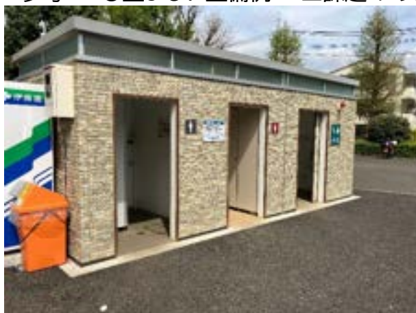
◎車椅子使用者用トイレが設置されている。
