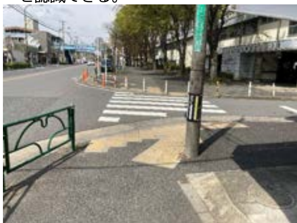
△視覚障害者誘導用ブロックの直近に電柱があり、通行の妨げになっている。
