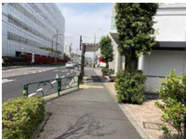
◎バス停留所に視覚障害者誘導用ブロックが敷設されており、視覚障害者が停留所を認識できる。
