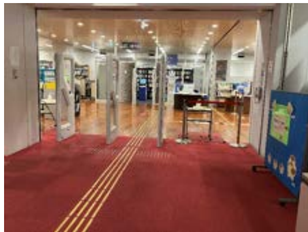
◎出入口から案内所までの連続した視覚障害者誘導用ブロックが敷設されている。
