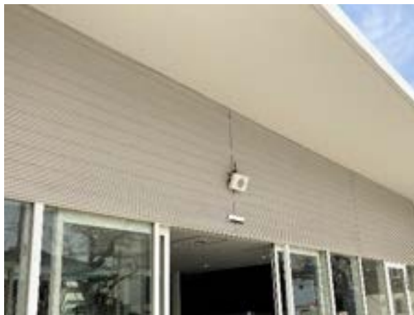
◎視覚障害者が出入口の位置を認識できる音声案内(シグナルエイドに対応)が設置されている。
