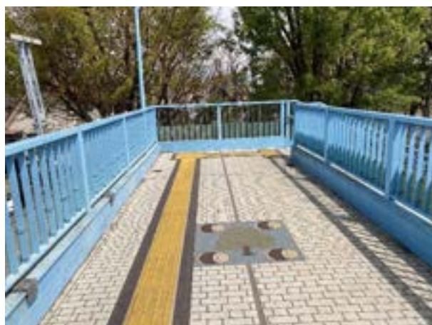
◎視覚障害者誘導用ブロックに黒色の側帯を設けることで、より輝度比を確保している。
