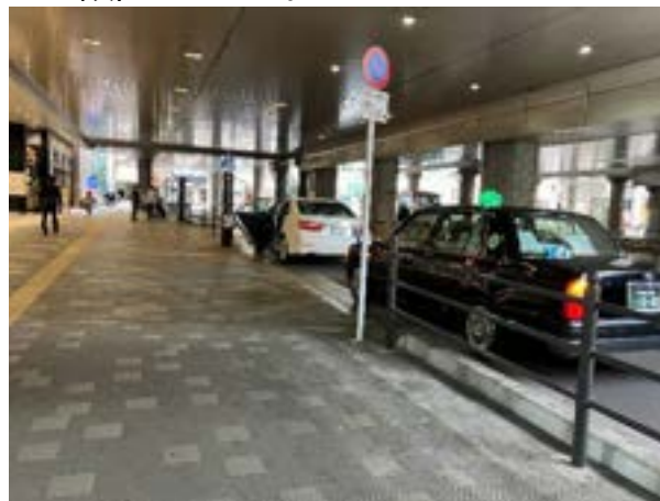
◎タクシー乗り場は平坦部が確保され、連続した視覚障害者誘導用ブロックが設置されている。
