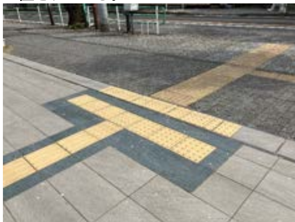
◎道路と沿道施設の視覚障害者誘導用ブロックが連続している。
