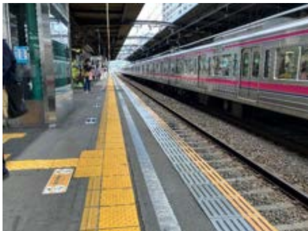
△ホームドアまたは可動式ホーム柵が設置されていない。
