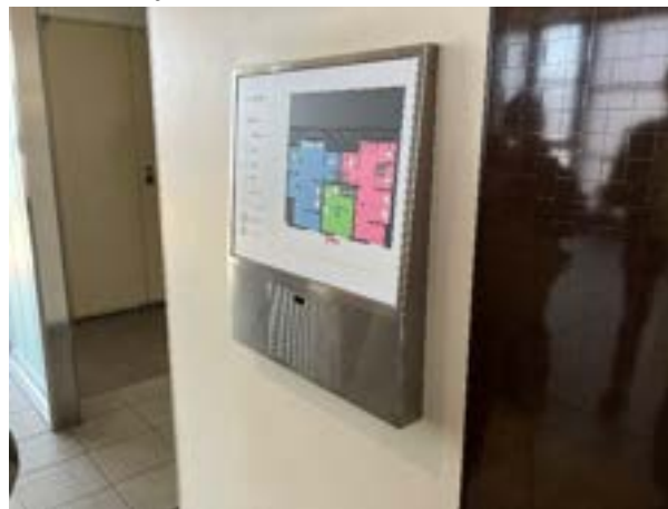
◎トイレ出入口に触知案内図や音声案内を設置している。
