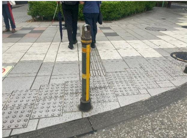
写真6 (マンホールで誘導用ブロックが途切れている例)
