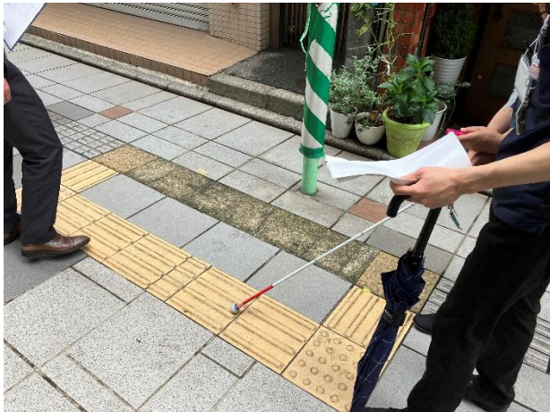
写真5 (マンホールで誘導用ブロックがずれている例)
