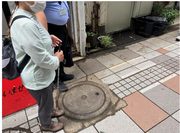
写真6 (マンホールで誘導用ブロックが途切れている例)
