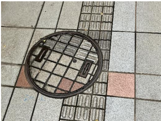
写真5 (マンホールで誘導用ブロックがずれている例)
