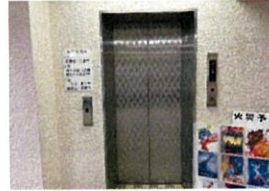
エレベーター外観
