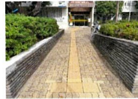
視覚障害者誘導用ブロック
