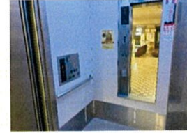
エレベーター内観
