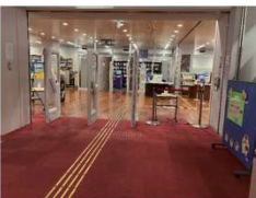
出入口から案内所までの連続した視覚障害者用誘導ブロック
