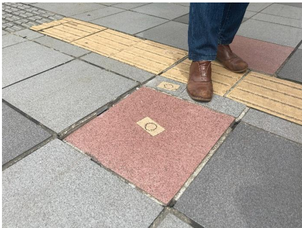
写真3 (誘導用ブロックの急な曲がりの箇所)
