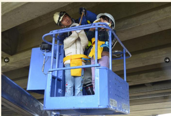
岡山 地域に根付くインフラ 橋梁点検
