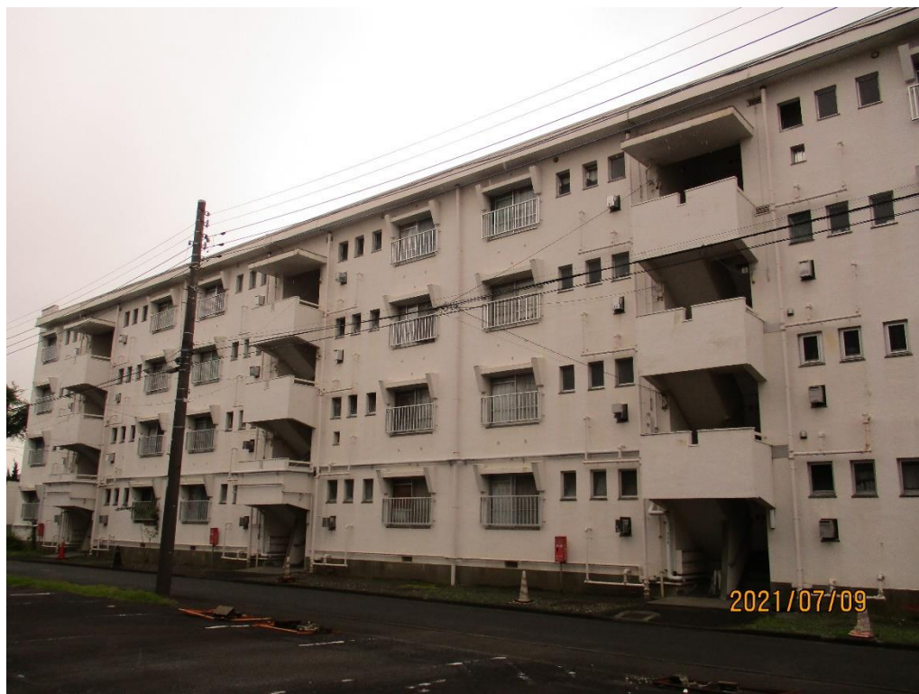
【写真2】エレベーター設置が困難である状況（事例：第十六小柳町住宅）
