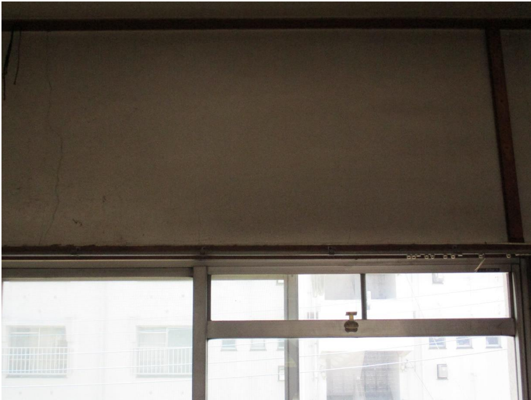
エアコン配管穴なし（窓上段の小窓を活用し、設置）
