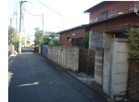
狭あい道路沿道のブロック塀や老朽木造住宅
