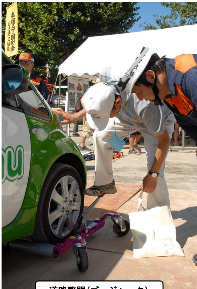
道路啓開(ゴージャック)
