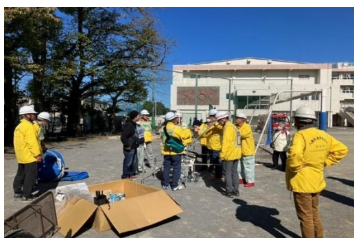
マンホールトイレの設置
