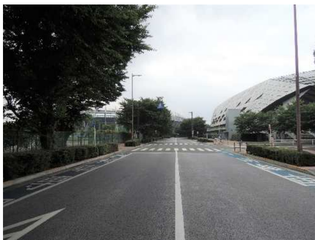
図 4.8 無電柱化されたスタジアム通り
