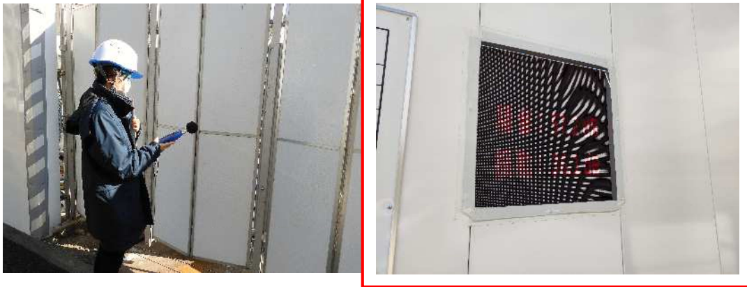
図 4.20 騒音調査の様子（左）と建設現場の騒音・振動レベルの電光掲示板（右）
