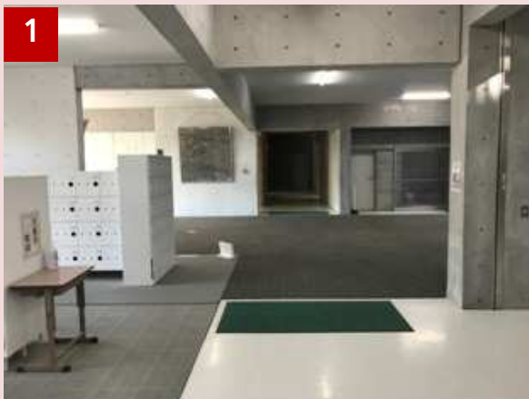
段差のない昇降口（立川市立第一小学校）
