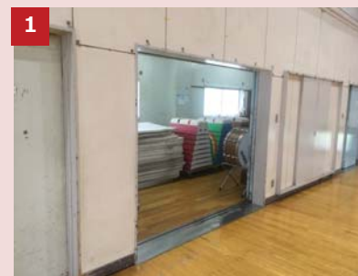
④体育器具庫の設置 (府中市立日新小学校)
