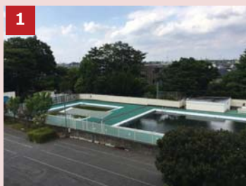
①小プール (府中市立四谷小学校)
