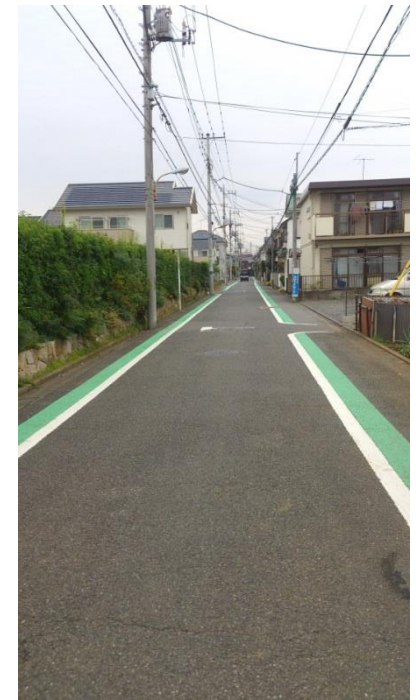
区画線 & 路側帯カラー舗装
