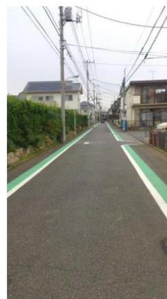
区画線&路側帯カラー舗装
