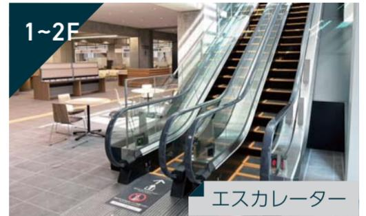
1Fロビーから2Fにかけてエスカレーターを設置しており、利用者の多い1Fと2Fの移動を円滑にします。誰もが快適に利用できるようにゆっくりとした速度設定としており、併せて音声ガイドにて乗降の誘導をします。
