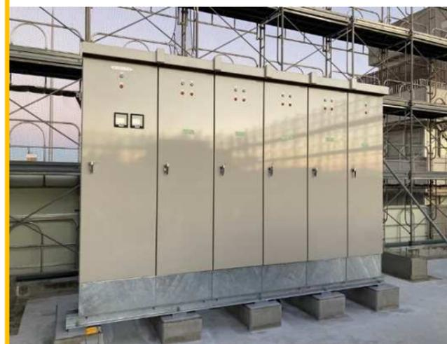
・分電盤は、変電所や電気室から送られてきた電気を、部屋の電灯やコンセント、設備機器に分配する役割を担います。電気の使い過ぎや漏電で事故が起きないように、漏電遮断器(ブレーカー)を取付けています。
