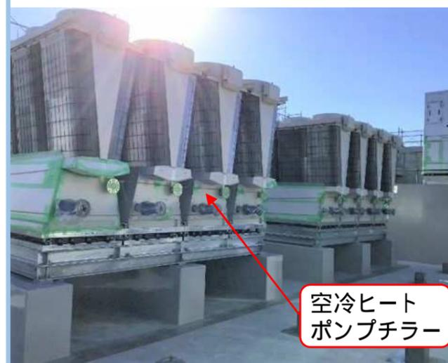
・建物の空気調和には、空気を冷やしたり、暖めたりするための熱源装置が必要となります。このため、庁舎の屋上には、熱源装置として空冷ヒートポンプチラーを設置しています。この装置は、外気温度を利用して、循環する液体を冷却・加熱し、冷却・加熱処理した冷温水を各所の空調機まで送っています。
