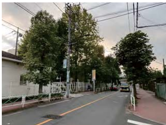
現在の北側歩道の様子
