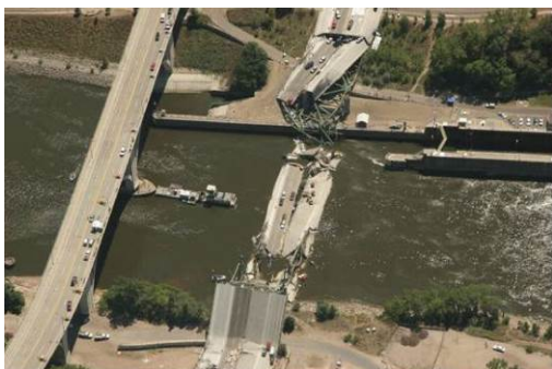
〔橋梁崩壊後の状況〕 「米国ミネアポリス橋崩壊事故に関する技術報告」（国土交通省）より
