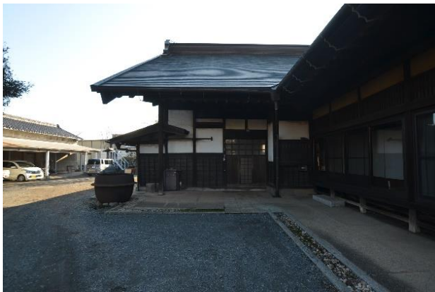
主屋外観 北面(大戸口) おとぐち
