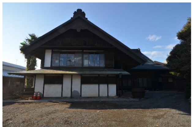
主屋外観 東面
