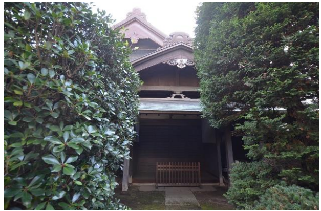
主屋外観 玄関(式台)
