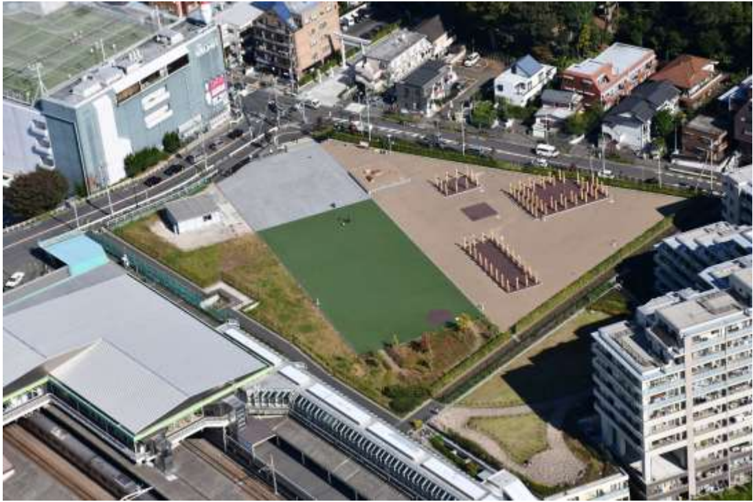
図 4 国司館地区第 1 期整備事業完成時全景（南西より）
