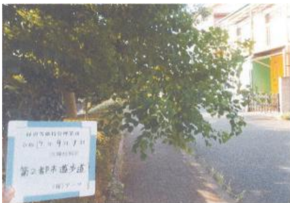
通行の支障にならないよう剪定等を行います。
