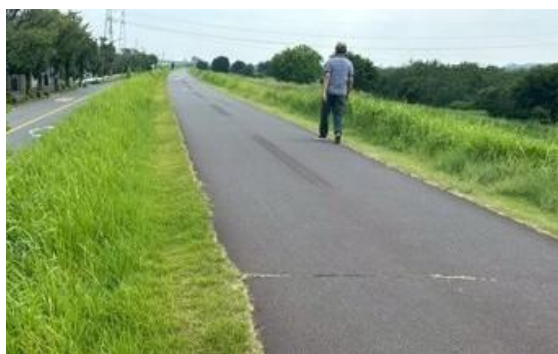
かぜのみち、草刈りの様子（作業前）
