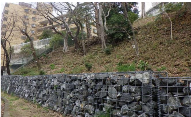
府中崖線本宿町緑地（本宿町 1-32-4） 土留めを設置していますが、できるだけ自然な景観になるよう蛇籠（ じゃかご 、金網などをカゴ状に組み石等を詰めたもの）を用いています。経年により内部に草が生えてくる予定です。
