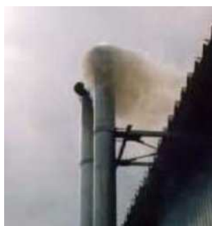
図 3-2 水分が規格外の燃料による白煙の発生状況
