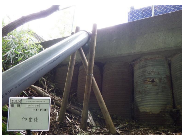
巡回で見つけた機能していない雨水配管。配管の修繕をしました。
